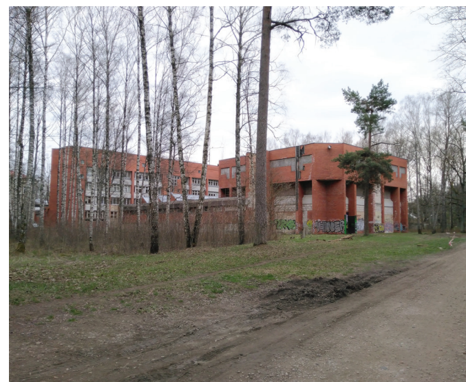
Degradējošs skats no Muižas ielas
