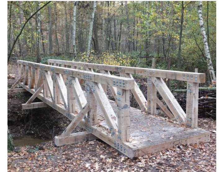
Koka konstrukcijas tiltiņš ar margām
