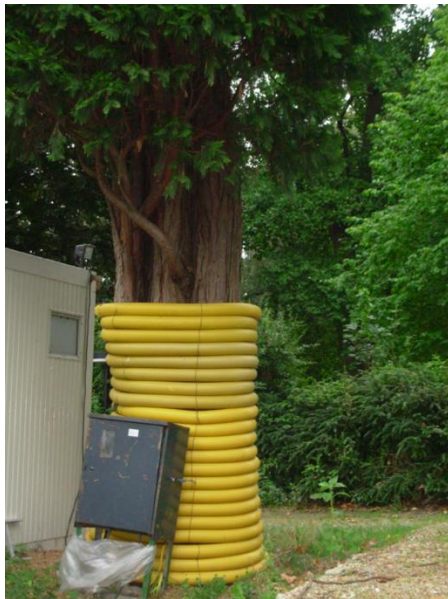
8. att. Koku stumbru aizsardzība izmantojot tikai gofrēto meliorācijas cauruli, Vācija, Nirnberga, foto Gvido Leiburgs
