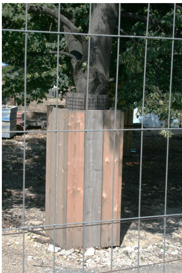
10. att. Dubults koka dēļu aizsardzības vairogs (ap stumbru un papildus kastesveida), sakņu zonā izlīdzināti drupināti būvgruži, Austrija, Vīne Šonbrunnas (Schönbrunn) pils parks, 2019. gads, foto Gvido Leiburgs.
