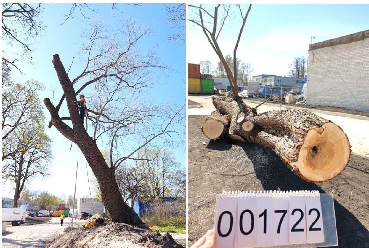
36. att. Vītola daļēja apzāgēšana un eko stumbeņa pārvietošana uz zaļo saliņu objektā, foto Gvido Leiburgs.
