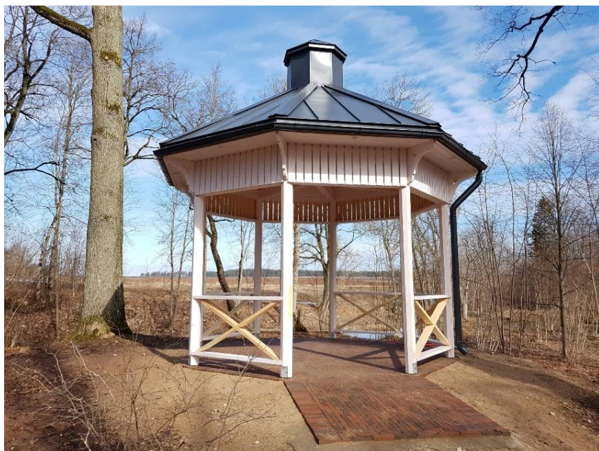
28. att. Būvdarbi lielo koku tuvumā, lapenes izbūve uz skrūvpāļiem Jaunpils parkā, 2018. gada februāris, foto Gvido Leiburgs.
