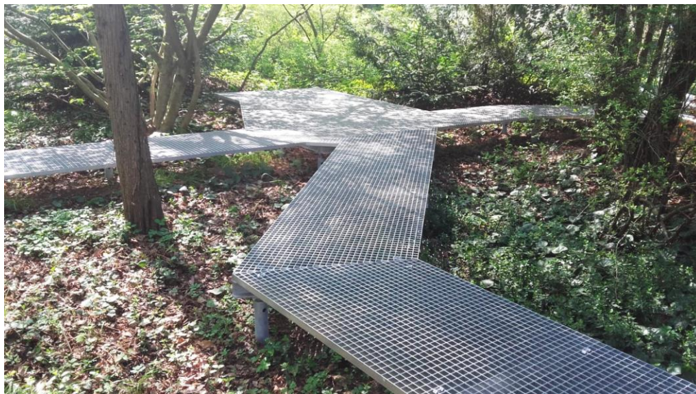
21. att. Metāla režģa gājēju celiņš uz punktveida pamatiem LU Botāniskajā dārzā starp kokaugiem un vaskulārajiem augiem
