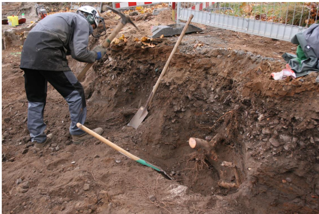
26. att. Sakņu atrakšana un apzāģēšana, Vācija, 2007. gads, foto Gvido Leiburgs.
