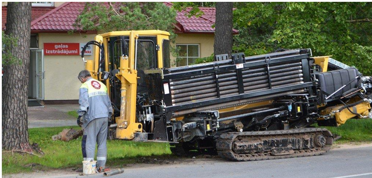
30. att. Beztranšeju tehnoloģijas, SIA BT Būve, http://btbuve.lv/galerija/ .
