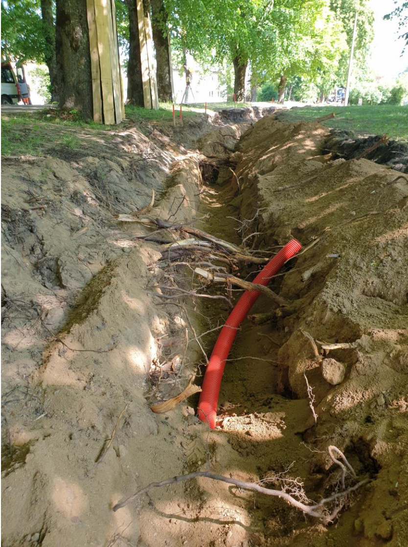
2. att. Redzama gājēju celiņa gultne kurā ir izrakta tranšeja elektrības kabeļa ieguldīšanai, strādājot ar traktortehniku aprauts liels skaits lielu dimensiju saglabājamu koku sakņu, darbi veikti koka minimālajā un kritiskajā sakņu aizsardzības zonā, foto Gvido Leiburgs.
