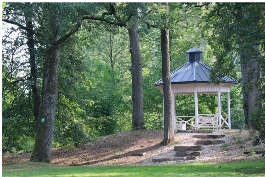
29. att. Būvdarbi lielo koku tuvumā, lapenes izbūve uz skrūvpāļiem Jaunpils parkā, attēls pēc būvdarbu pabeigšanas, https://www.gardenpearls.eu/darzi/jaunpils-parks/?lang=lv .
