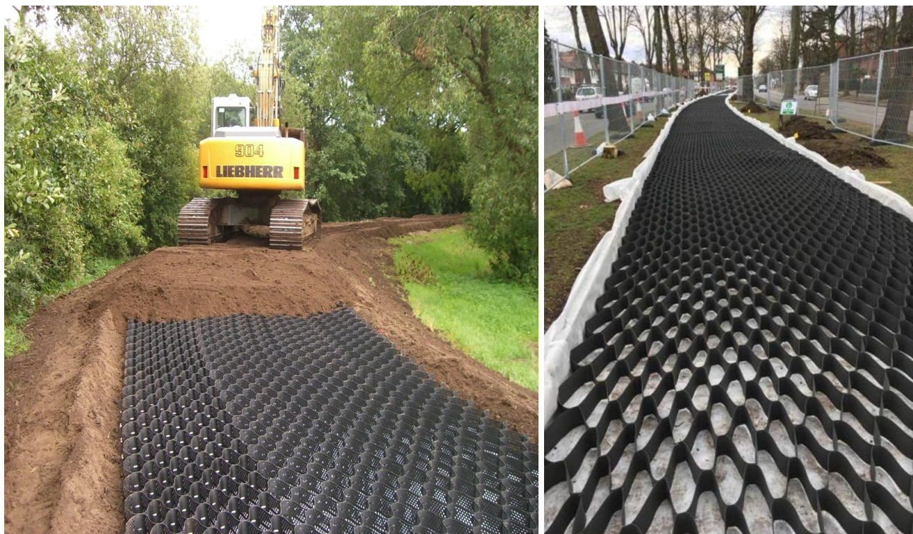
32. att. Geoweb® telpiskais ģeokompozīts, kas ērti izmantojams gan pagaidu, gan pastāvīgu ceļa konstrukciju izveidei koku sakņu zonā, neveidojot ierakumu, https://www.greentech.co.uk/search-results?keyword=root%20guard .
