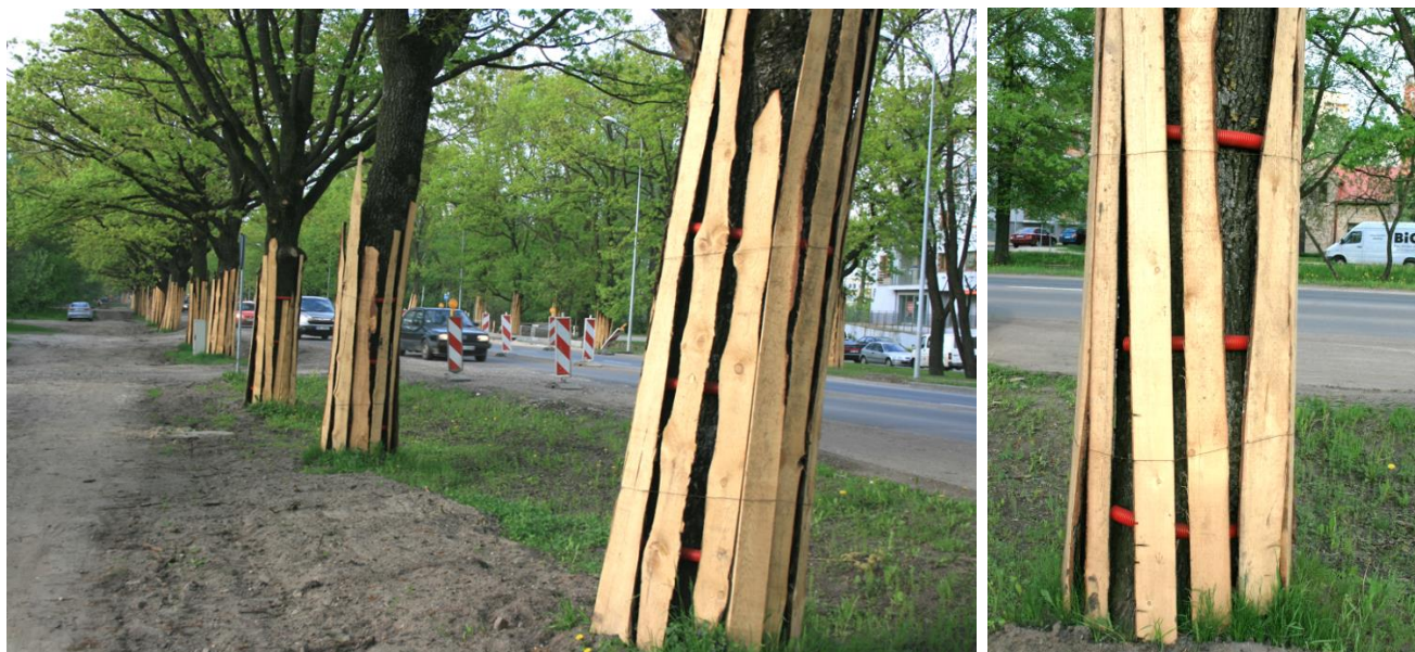
9. att. Koku stumbru dēļu aizsargi, kas montēti uz gofrētās plastmasas komunikāciju aizsargcaurules, Rīga, foto G.Leiburgs.
