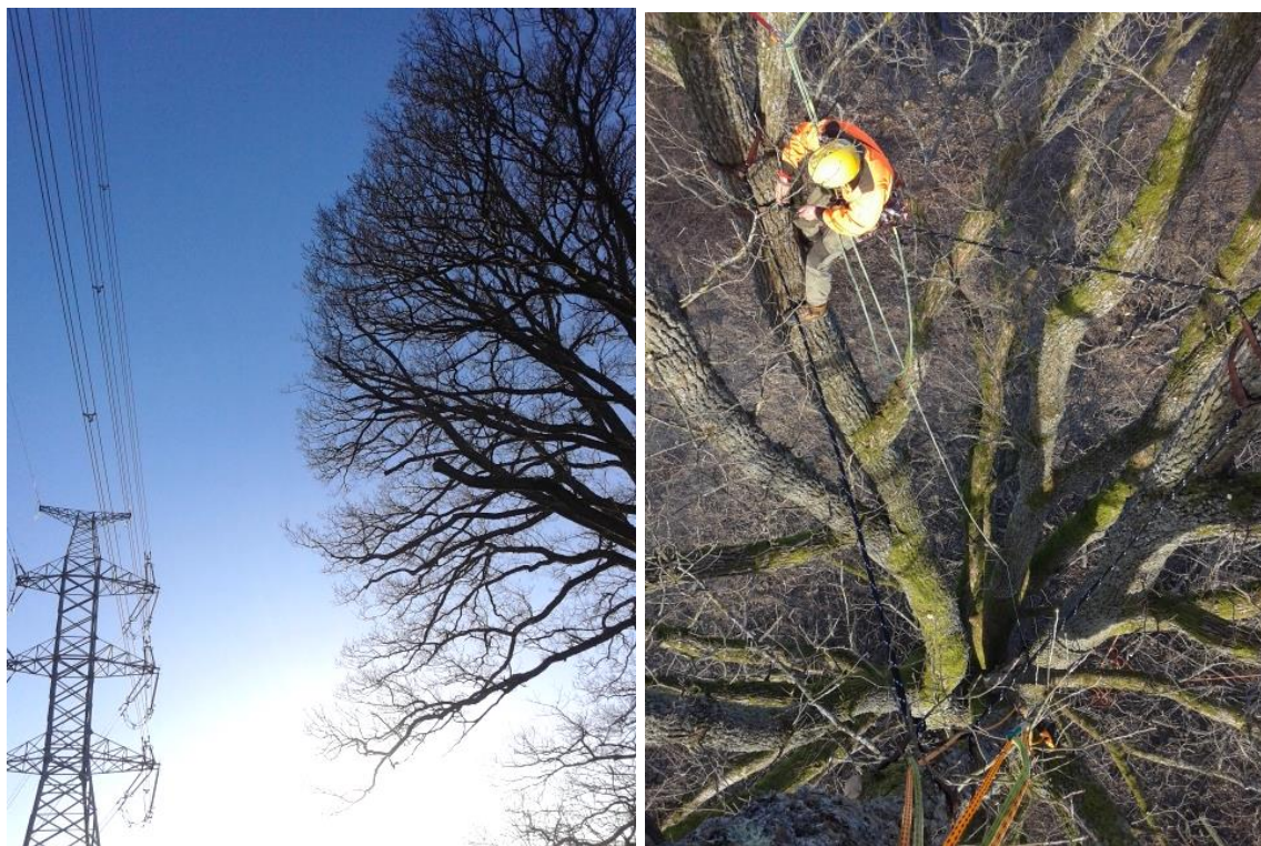
17. att. Kurzemes loka izbūves projekts, 110 KV elektrolīniju pastiprinot ar 330 KV līniju, veikta ozola (ĪADT statuss) vainaga vienas pusē samazināšana no elektrolīnijas puses un profilaktiska koka stabilizācijas sistēmu montāža, lai nodrošinātu līnijas drošību, 2014. gads, foto Jānis Strausmanis),
