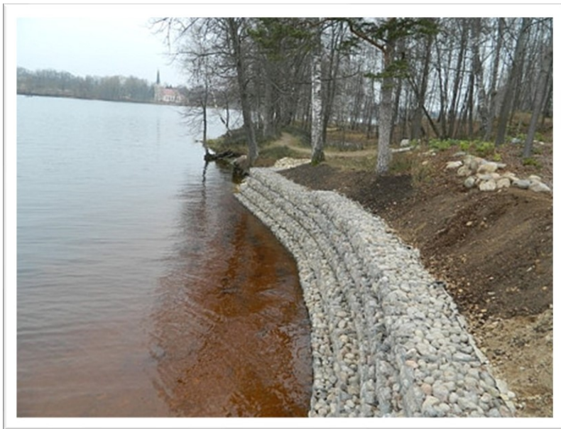
11. Attēls. Gabionu matraču izmantošana krasta stiprināšanai
