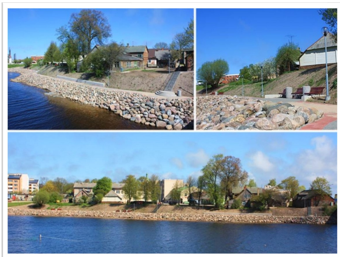
12. Attēls. Gabionu matraču izmantošana krasta stiprināšanai
